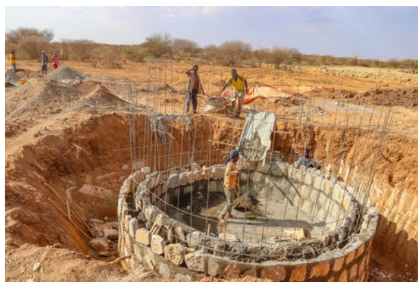
Bygging av en demning i Hargalle i Etiopia som en del av et prosjekt for å støtte 3000 bondefamilier som er rammet av tørke
